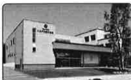
国道 16 号 大横町 八王子大横町会館 八王子市大横町 14-22
