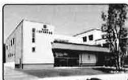
国道16号大横町 八王子大横町会館 八王子市大横町 14-22
